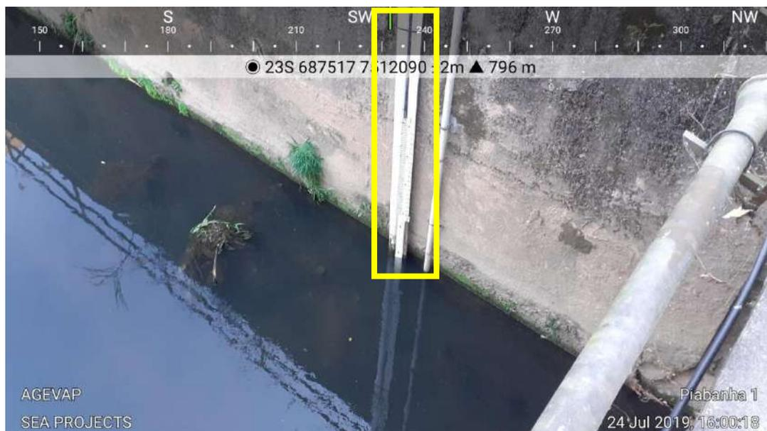
Figura 3.1-4: Régua de nível instalada no Ponto 1.
