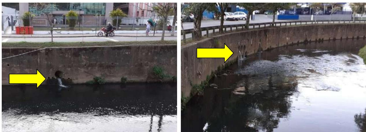
Figuras 3.1-5 e 3.1-6: Detalhe do deságue da rede de drenagem do Ponto 1.
